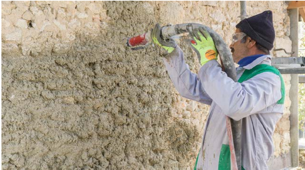
PARNATUR®, el primer mortero de aislamiento térmico y acústico "fácil de rociar" a base de cáñamo
