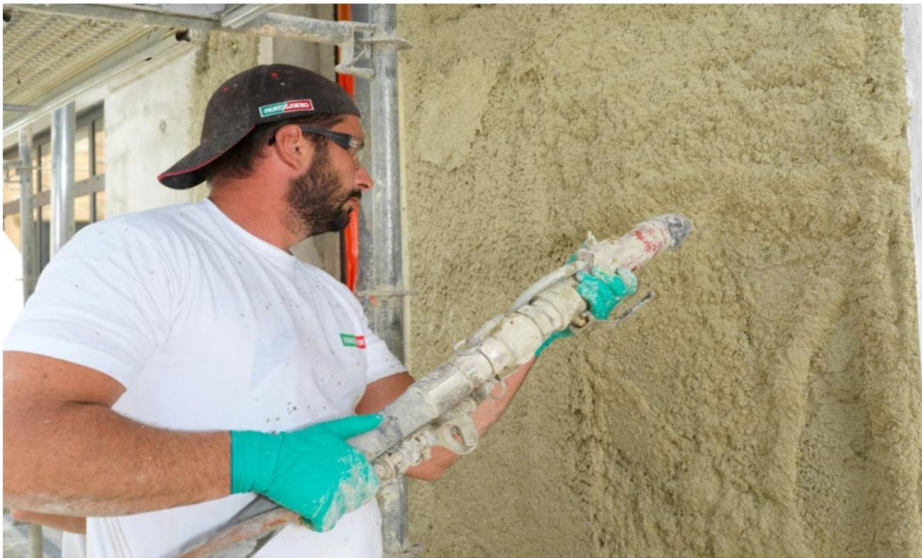
PARNATUR® el primer mortero "fácil de proyectar" a base de cáñamo para el aislamiento térmico y fónico
