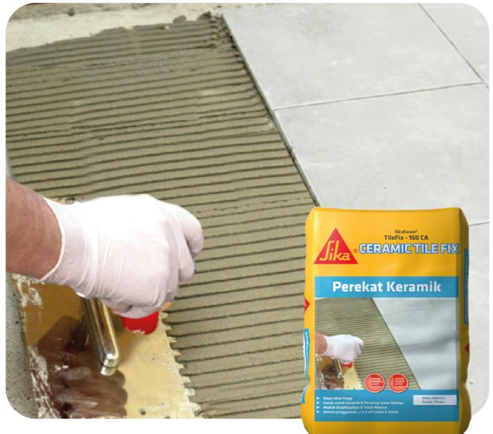
Semen instan untuk perekat keramik pada lantai dan dinding, serta penutup lantai lainnya pada lantai, dengan ketebalan aplikasi  $\pm 3$  mm.
